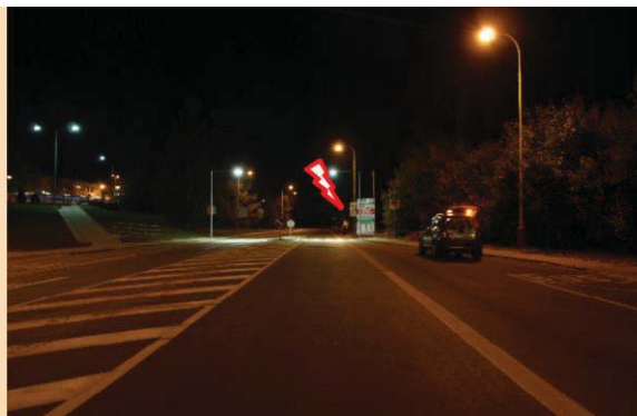
Osvětlený přechod 1 s adaptační zónou
